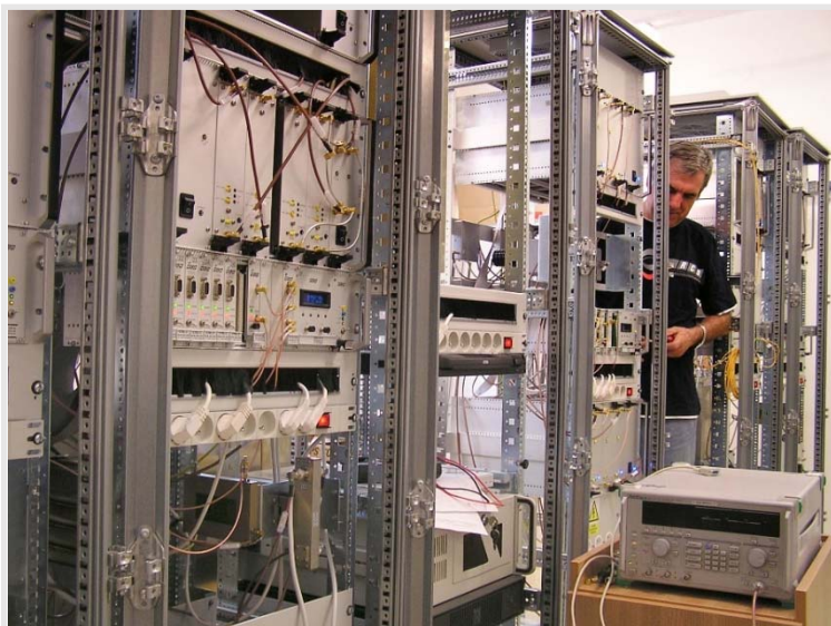
Montáž technologie silničního tunelu
