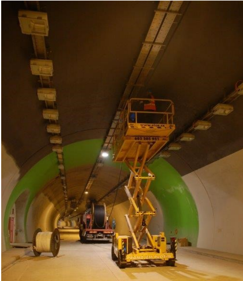
Instalace vyzářovacího kabelu v silničním tunelu Klimkovice
